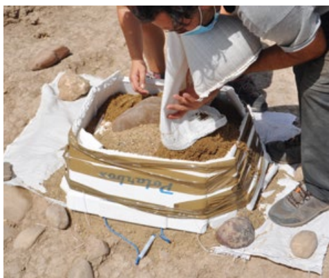
Proceso de protección particularizada de una instalación productiva realizada en tierra cruda con geotextil, tela de rafia sintética, planchas de poliestireno expandido y arena lavada de río. Cerro Macareno. La Rinconada, Sevilla, 2021. Fotos: Francisco José García Fernández
